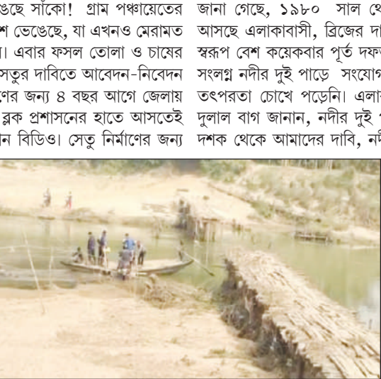
চৈতন্যপুরে শিলাবতী নদীর উপর কাঠের সেতু নির্মাণ করেছিল গ্রাম পঞ্চায়েত। নদী পারাপারে এই সেতুর উপর নির্ভরশীল চৈতন্যপুর, কেশেডাল, নিশিচন্ডপুর, পরমানন্দপুর, পাঁচানি, ঘোষকিরা, ধর্মপোতা, কৃষ্ণপুর-সহ ২০-২৫ গ্রামের বাসিন্দারা। ভগবন্তপুর-১ ও ভগবন্তপুর-২ গ্রাম পঞ্চায়েতের সংযোগস্থাপন করে কাঠের সেতুটি। এছাড়াও নদী পেরিয়ে যাতায়াত করতে হয় স্কুল-কলেজ, হাসপাতাল থেকে বাজারহাটের জন্য। কৃষিকাজের জন্যও যাতায়াত করতে হয় এলাকার কৃষকদের। গত বন্যায় শিলাবতীর জলের তোড়ে ভেঙে গেছে কাঠের সেতুর একাংশ, নদীতে জল থাকায় ভাঙা সেতুর পাশেই ঝুঁকি নিয়ে চলছে নৌকায় যাতায়াত। চাষের মরসুম খান তুলে আলু চাষ শুরু হয়েছে এলাকার, চাষের সামগ্রী বাজার থেকে কিনে বাড়ি নিয়ে যেতে ভরসা নৌকা, তাতে চরম দুর্ভোগে পাতে হচ্ছে কৃষকদের। চাষের সামগ্রী ট্রাক্টরে করে নদীর জল পেরিয়ে নিয়ে যেতে গিয়ে দুর্ঘটনাও ঘটেছে, নদীর জলে ডুবে গেছে একটি ট্রাক্টর। তাকে উপেক্ষা করেই চাষের সামগ্রী নিয়ে নদীর জলে ডুবে ঝুঁকি নিয়ে যাতায়াত করছে ট্রাক্টর। এককথায় নিতাবাড়ী থেকে এলাকার কৃষকদের নদীপারে চরম ভোগান্তির শিকার হতে হচ্ছে বলে দাবি তাদের। আর এতেই ফ্লোডে ফুঁসছেন এলাকার বাসিন্দারা। দীর্ঘ ৪৫ বছর ধরে শুনে আসছে তাদের এলাকায় ব্রিজ হবে কিন্তু আজও তা অধরা। পঞ্চায়েত, বিধানসভা হোক কিংবা লোকসভা ভোট, ভোট এলেই সব রাজনৈতিক দলের মুখে ব্রিজ করে দেওয়ার প্রতিশ্রুতির বন্যা বর, কিন্তু ভোট মিটলেই আর কারও তৎপরতা দেখা যায় না, অভিযোগে এলাকাবাসীরা। প্রতি বছর বর্ষায় নদীর জল বাড়লেই যোগাযোগবিচ্ছিন্ন হয়ে যায়, বন্যা হলে তো দুর্ভোগের শেষ থাকে না-- এমনই জানাচ্ছেন ডুঙ্গভোগী এলাকাবাসী।
