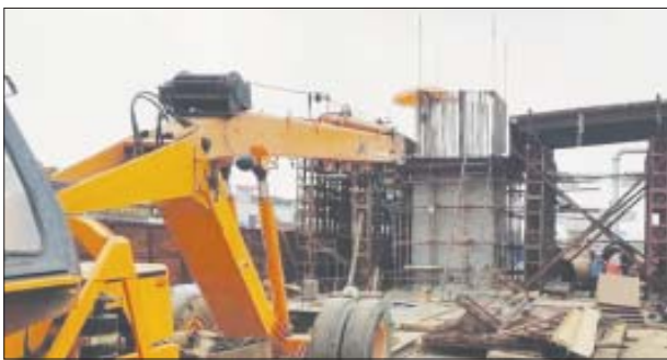
রাজারহাটে মেট্রো প্রকল্প (অরেঞ্জ লাইন) হয়ে নিউ গড়িয়ার ভিআইপি বাজার মেট্রো স্টেশন (কবি সুভাষ) থেকে বিমানবন্দর পর্যন্ত ভায়াডাক্টের নির্মাণ কাজ চলছে।
